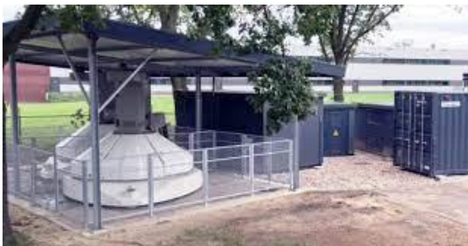
Рис 3 – Гибридный проект компании «Kinext» (слева маховичные накопители, справа контейнеры с литий-ионными аккумуляторами)
