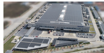
PEDJMの太陽光発電システム
