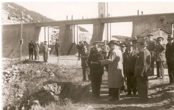
Izquierda: Construcción de presa de Rosarito, Cáceres.
