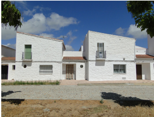
Fig. 3. Viviendas de colonos en Vegaviana, Cáceres, y nuevos viales empedrados.
