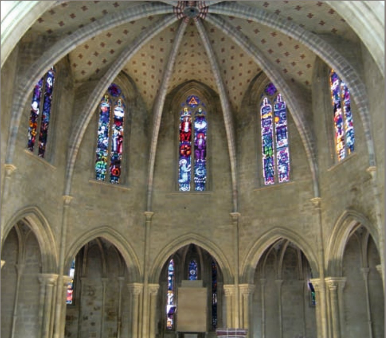
Absis gòtic interior de la parròquia del Salvador de Borriana. Procés de restauració al setembre de 2008. (Foto: J. Bort).
