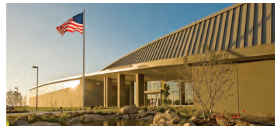
PLANTA DE TRATAMIENTO DE AGUA "PLATTE WEST"
