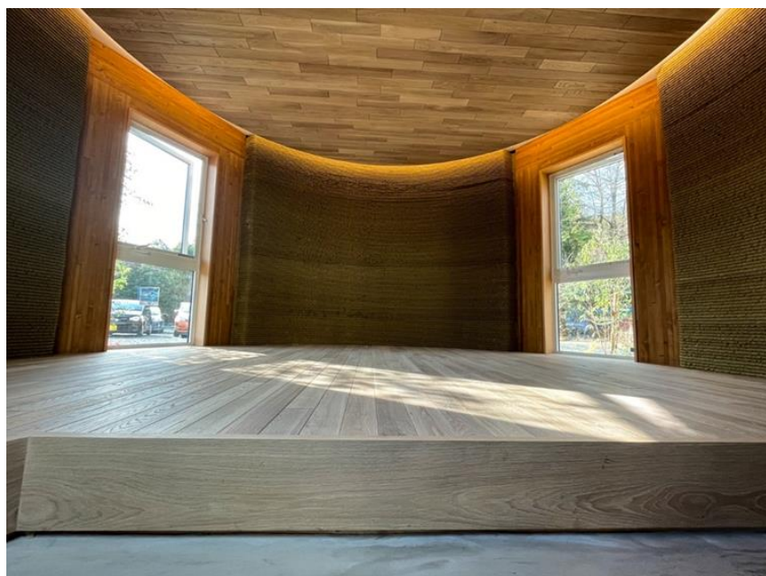
3Dプリンターモデルハウス 「Lib Earth House “modelA”」 建設地：熊本県山鹿市
