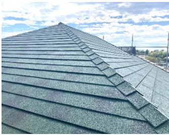
【屋根カバー工事】
