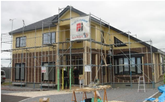
【施工現場全景】
