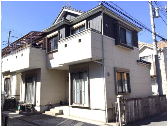
【既存外壁材】 【窯業系サイディング】
