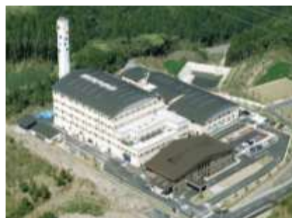
ごみ焼却・溶融プラント
