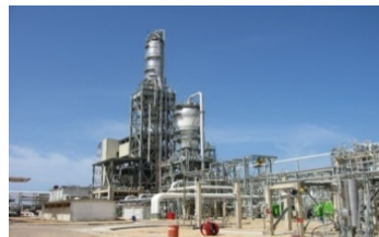
ポリエチレンプラント
