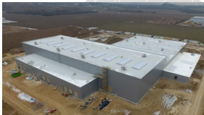
建設中の工場 (2019/1現在)
