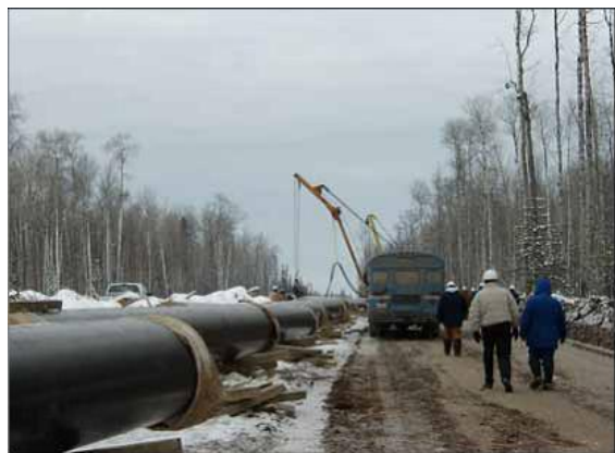
カナダのパイプライン
