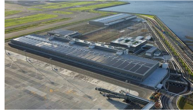
羽田空港の再拡張・国際化に合わせ開業した国際貨物ターミナル事業 〈東京国際エアカーゴターミナル株式会社〉
