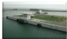
廃液貯蔵(カフポート)
