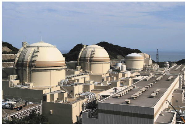
国内PWRプラント(関西電力(株)大飯発電所)
