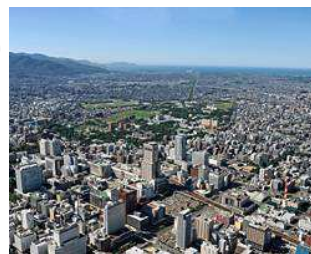
札幌駅北口地区 地域冷暖房施設
