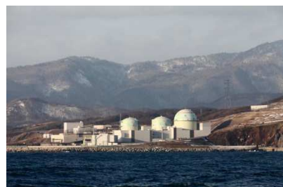
北海道電力(株)泊発電所1/2/3号機 (古宇郡泊村)
