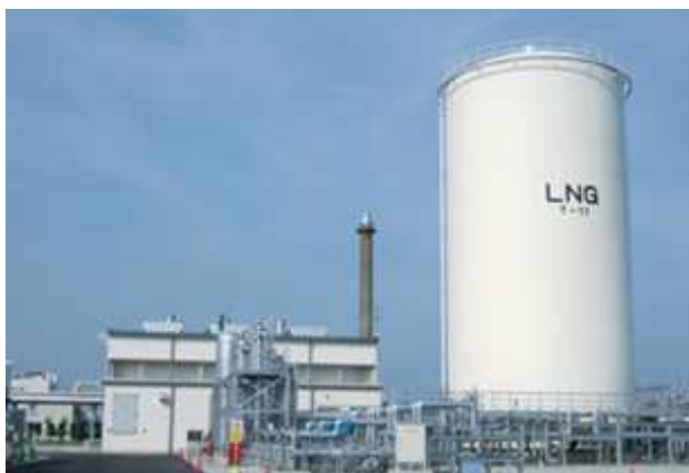
国内主要6工場の天然ガス導入完了で 16万トンのCO 2 削減
