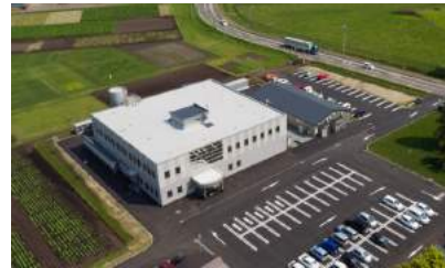
雪印種苗株式会社 北海道研究農場新研究棟 2017.6月竣工
