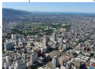
札幌駅北口地区 地域冷暖房施設
