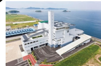
廃棄物処理設備
