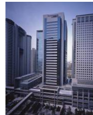
本社ビル(品川) [撮影 木田勝久/FOTOTECA]
