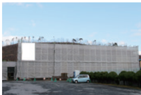
伊保内小学校体育館の屋根を改修中
