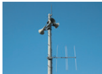
防災無線のデジタル化工事に着手します
