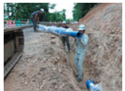
上下水道の接続率向上を図ります
