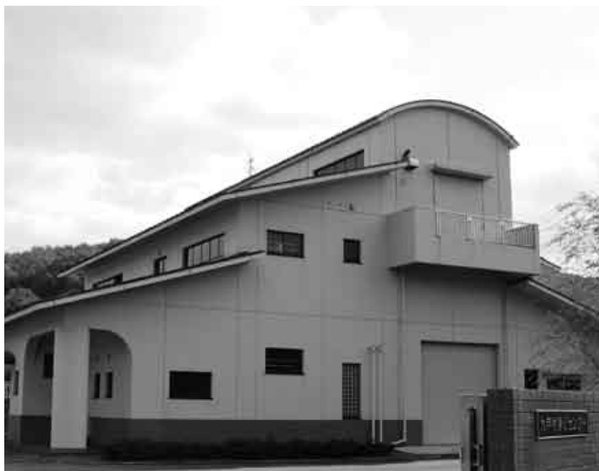
合併処理浄化槽の普及や水洗化率の向上のため、補助事業を継続していきます
