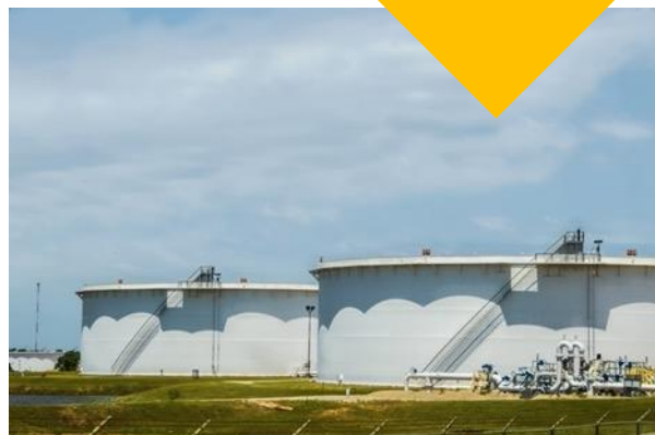
クッシング石油貯蔵施設
