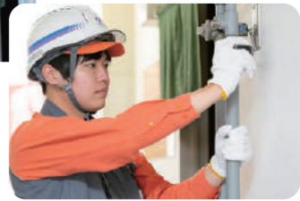
応急処置を行って作業を終了
