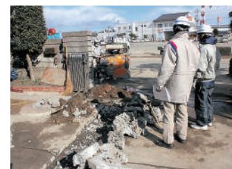
お客さまのご協力のもと、敷地内のガス管修理を実施
