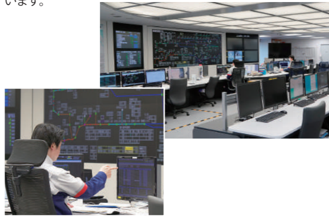
供給指令センター
