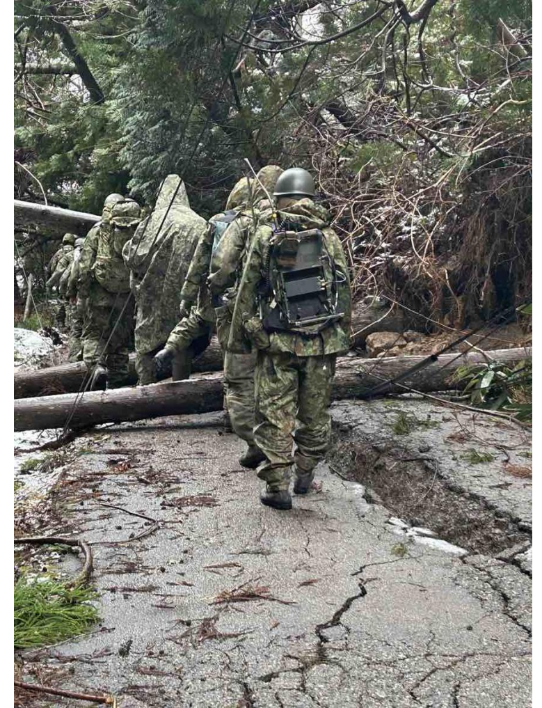
輪島市大沢町付近
