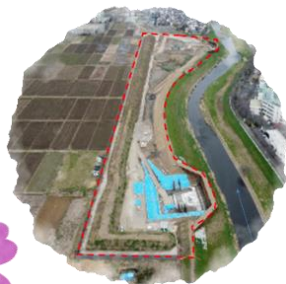
河川改修や調節池の整備・質的改良
