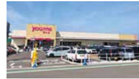
広い駐車場を整備
