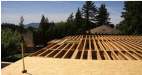
Pacific Woodtech社製単板積層材を使用した住宅用構造材
