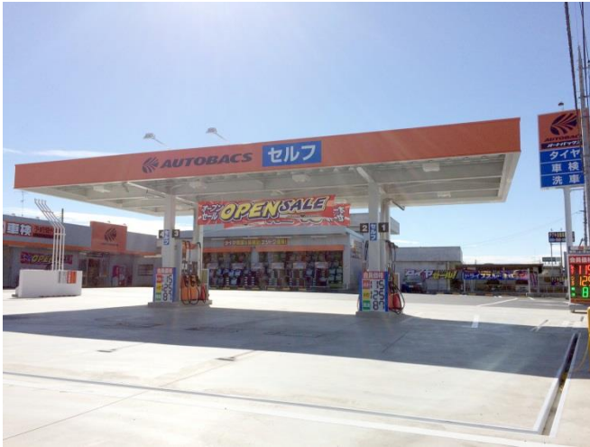
AB 館林諏訪町店・外観①
