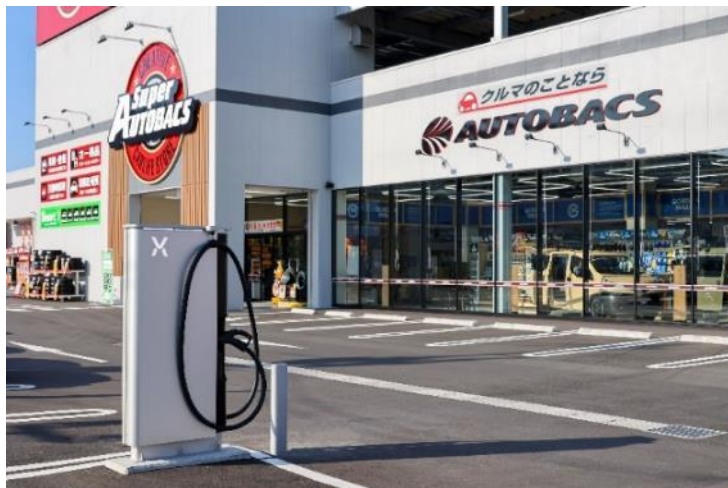
2024年1月に広島市内初の蓄電池型 超急速 EV充電器を設置 スーパーオートバックス広島観音新町(広島県広島市)
