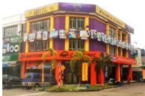
マレーシア セリオキッド店 (10月2日オープン)
