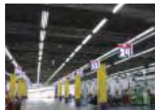
省エネタイプの蛍光灯が導入されているピット
