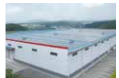
太陽光発電設備
