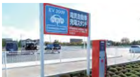
電気自動車(EV)用充電スタンドの設置
