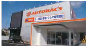
太陽光発電パネルの設置例 (オートバックス大和郡山)
