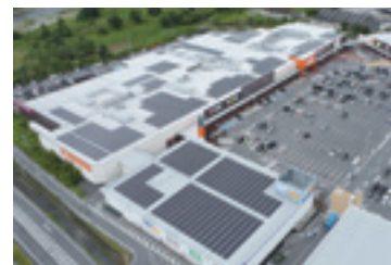
太陽光発電設備(イオンタウン湖南)
