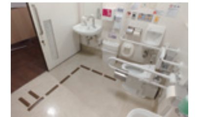
多目的トイレ内誘導用床ガイド (イオンタウン茨木太田)
