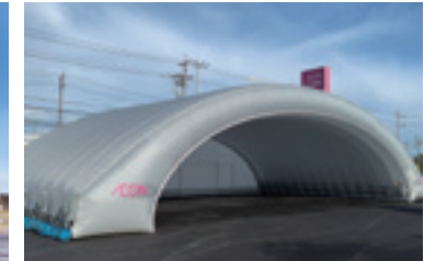
防災バルーンシェルター (イオンタウン四日市泊)
