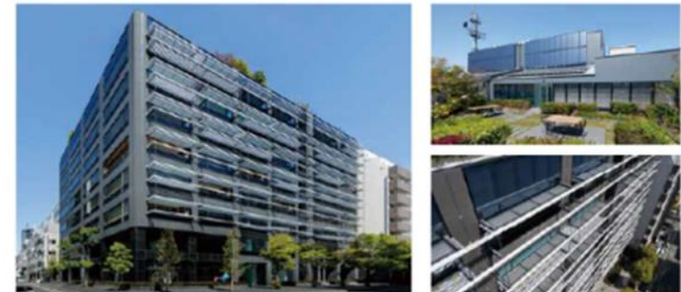
リニューアル工事② 外付け多機能ルーバーや窓部にシーソータイプ、壁面にソリッドタイプを採用
