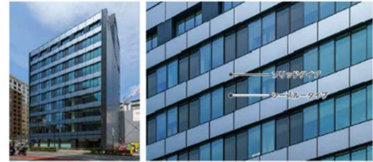
リニューアル工事① 外壁のスパンドレル部にソリッドタイプ、執務室窓にはシーソータイプを採用
