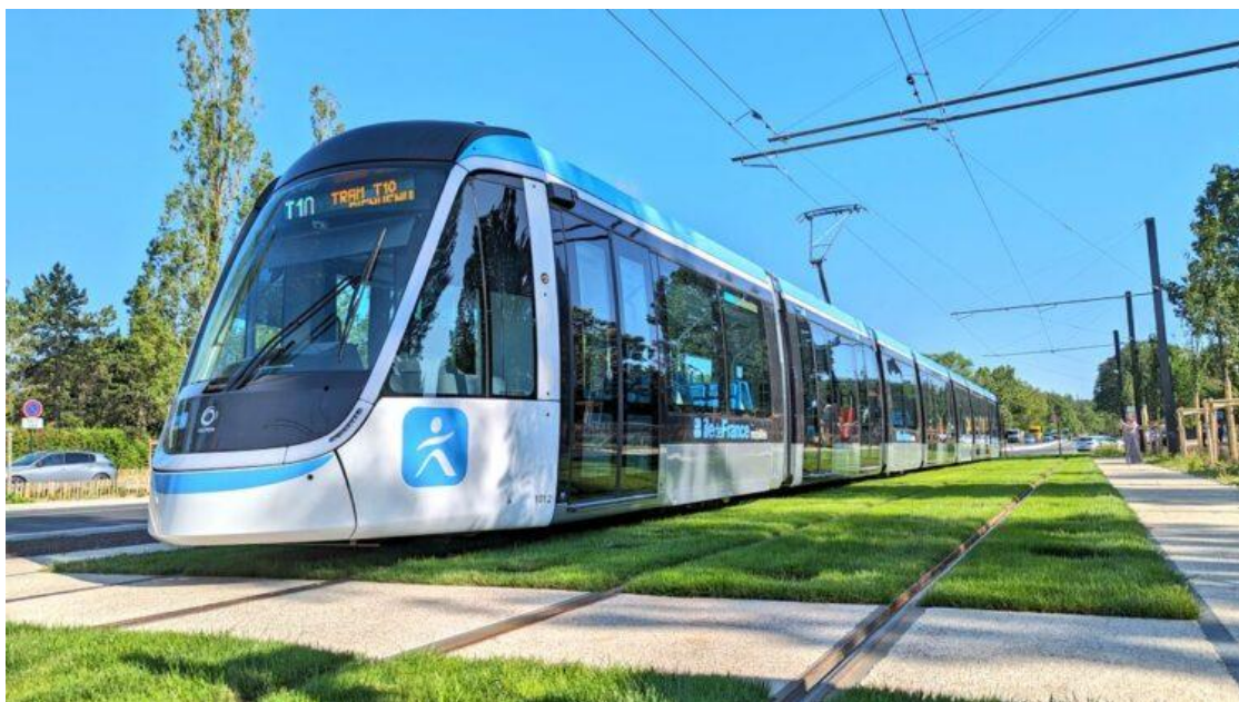
La plateforme du tramway T10
