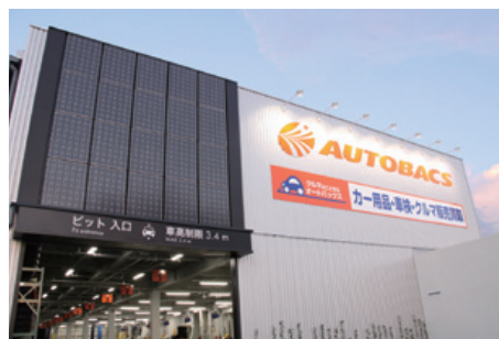
環境配慮型店舗(太陽光パネル設置)
