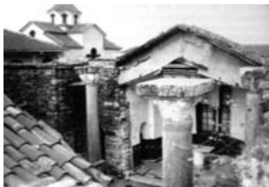
Εικ. 3: Ἐπιπέδωση τοῦ ἐρειπωμένου ναοῦ πρὶν ἀπό τίς ἐργασίες ἀναδόμησης (φωτ. Π. Στρούλιας).
