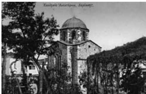
Εικ. 1. Έκκλησία Ανακτόρων Λαρίσης. Έπιστολικό δελτάριο του Γεωργίου Βελώνη, στο οποίο απεικονίζεται ο ναός του Αγ. Βησσαρίωνος στην άρχαία του μορφή. Φωτογραφία άρχών του 20ού αιώνα.
