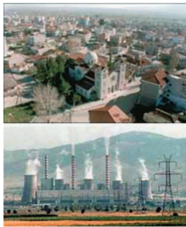
Εικόνα 39.6: Εργοστάσιο Δ.Ε.Η. στη Μεγαλόπολη
