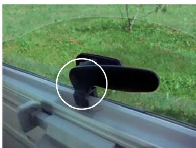
Il est possible de laisser les fenêtres entrouvertes en positionnant la poignée dans la rainure du verrou.
