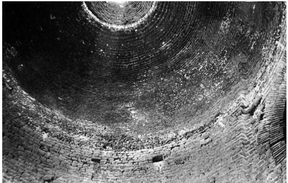
Fig. 8. Pergamo, Iseo. Cupola dell'edificio circolare meridionale, con intradosso in opera laterizia (da KOESTER 1998, p. 138 fig. 13).
