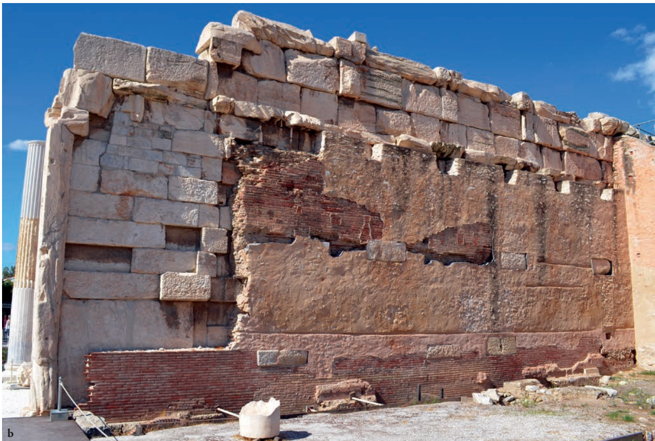
Fig. 3. Atene, Biblioteca di Adriano: a. Sezione del sistema di fondazioni e costruzioni presso il propileo di accesso (da TIGGINANKA 2008, p. 137 fig. 2); b. Muro occidentale di fondo del portico interno, con cortina laterizia (foto dell'A.).
