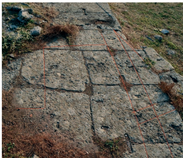
Fig. 11. Pergamo, Asklepieion , veduta di parte del tracciato progettuale inciso sul podio del Tempio di Zeus-Asclepio (foto e rielaborazione dell'A.).
