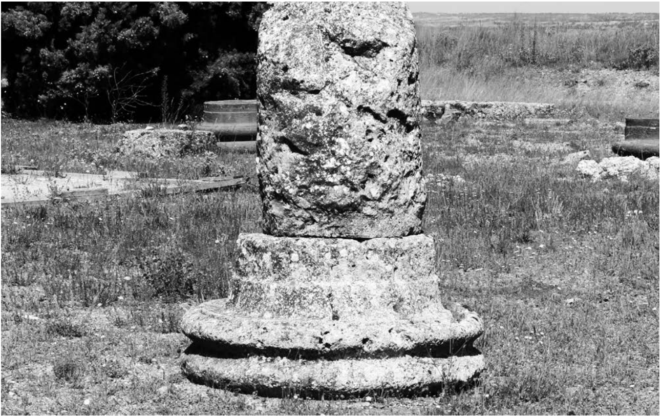
Fig. 16. Clunia, Basilica. Base del colonnato interno, veduta di dettaglio (foto dell'A.).
