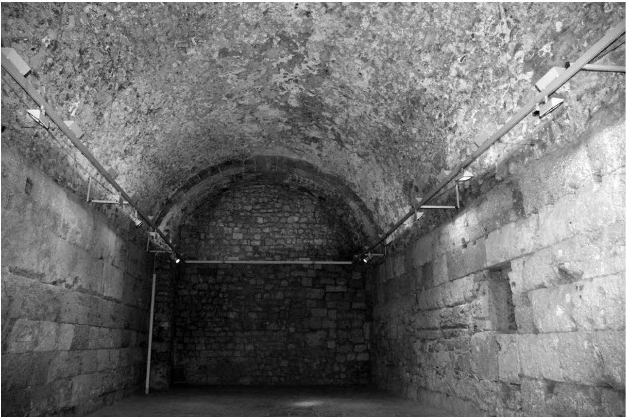
Fig. 10. Tarragona, Foro Provinciale. Terrazza intermedia, settore orientale: veduta della volta a botte impiegata nel secondo livello del criptoportico (foto dell'A.).
