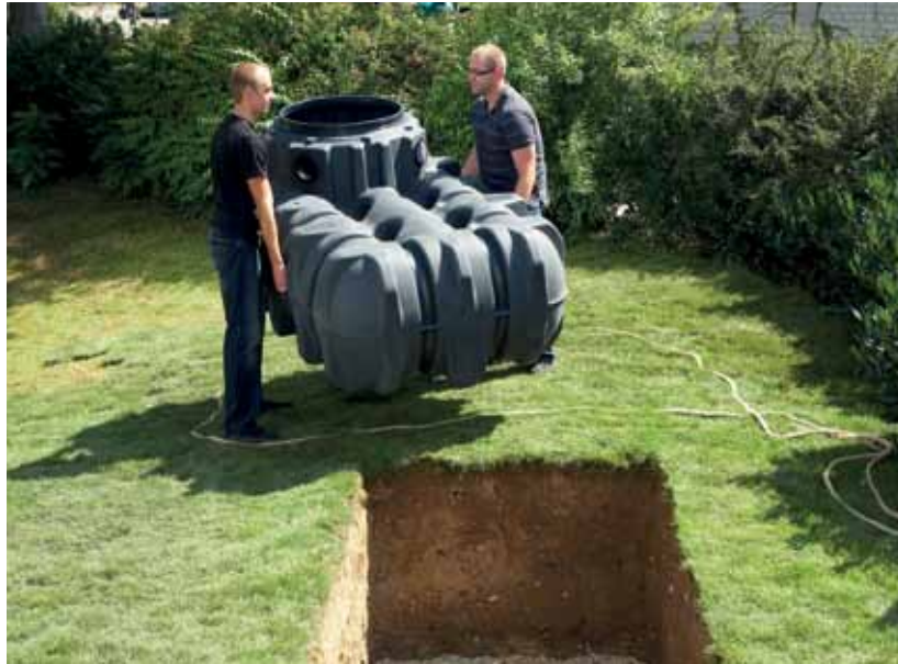
Regenwasserzisterne bei der Montage: Manche Kommunen geben Geld dazu
