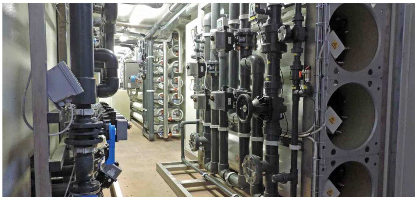
Osmosi Inversa doppio passo con EDI (acqua ultrapura) – 40 mc/h
