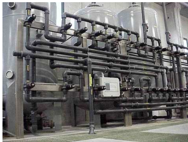
Gruppo valvole Polishing Selettivo - 15 mc/h
