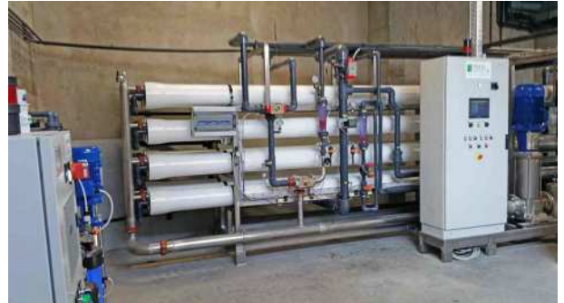
Scarico zero - 50 mc/h - con doppio stadio concentrato e doppio passo permeato
