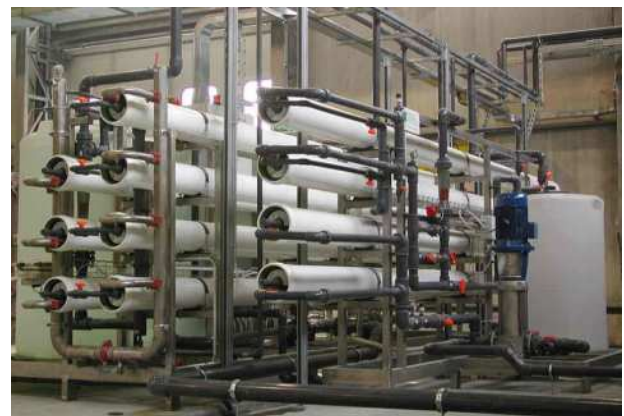
Nanofiltrazione 30 mc/h per riciclo scarichi con doppio passo permeato e doppio stadio concentrato
