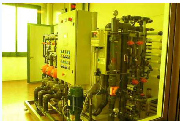
Impianto ultrafiltrazione sviluppo dry/film – 200 lt/h
