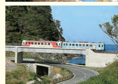
④ ハイベ沢橋梁 島越一田野畑間にある。津波で流失したが橋脚、橋桁等の構造物が一体化された世界初の橋梁として復旧。近くのハイベ浜は隠れたジオサイト
