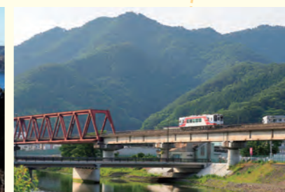
⑦ 大渡川橋梁 平田一釜石間 釜石の町と港が車窓に広がる 釜石駅から徒歩10分
