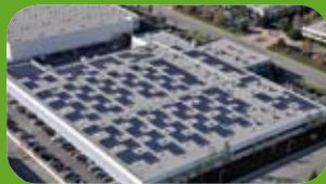
북미 QA-Lab에 설치된 태양광 패널
