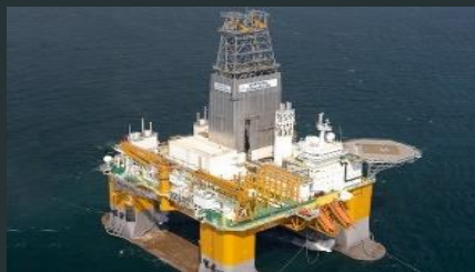
해양 Plant 단열재
